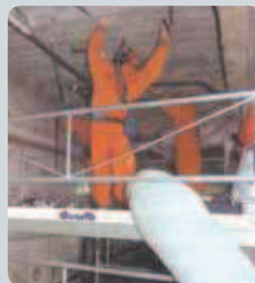
Des conditions de travail idéales pour le déflocage de l'amiante.
