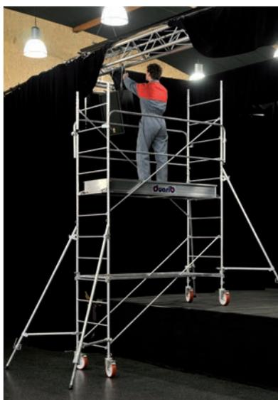
L'Altitude Acier s'installe dans les escaliers sans recours à une pièce optionnelle, au moyen de la base réglable en hauteur.
